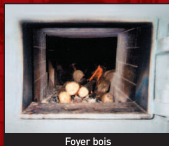
Blocs réfractaires équipant le foyer
