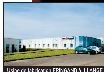
Usine de fabrication FRINGAND à ILLANGE
